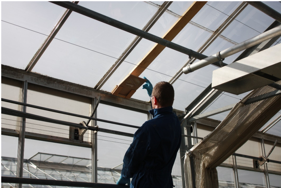
Billede 2. Isætning af træplade med monteret underskål i holder ved trempel.
