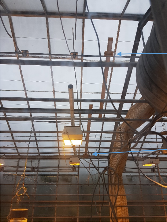
Billede 1. Placering af de to målesteder ved kip samt ved trempel. Holderne til prøver er markeret med pile.
